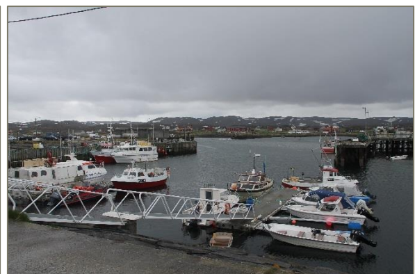
Figur 12. Liggeplasser innenfor Ringskjærmoloen (område for utdypning). Foto: Rambøll.
