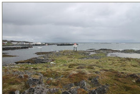
Figur 11. Havnebassenget sett fra Beritbuktnes mot Ringskjærmoloen og Gamvik Seafood. Barden i bakgrunnen. Foto: Rambøll
