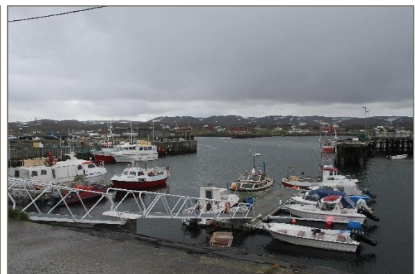
Figur 13. Liggeplasser innenfor Ringskjærmoloen (område for utdypning). Foto: Rambøll.
