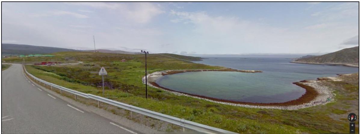
Figur 3: Planområdet sett fra Fv 263 mellom Mehamn og Gamvik. Siktretning er mot nordvest. Planområdet for Mehamn mottaksstasjon sees til venstre i bildet. Kilde: Googlemaps.
